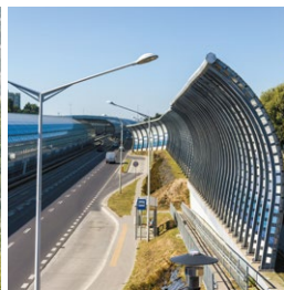
高速道路遮音壁
